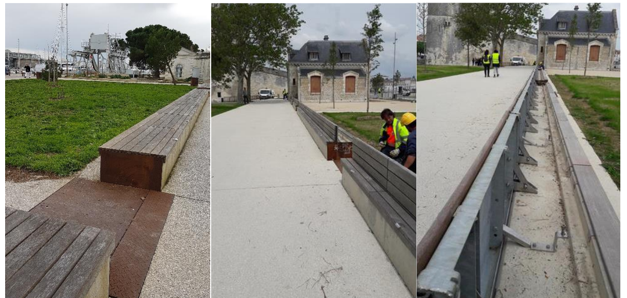
3 Système de bancs à assise relevable relayés par des batardeaux intégrés dans le sol ou amovibles
